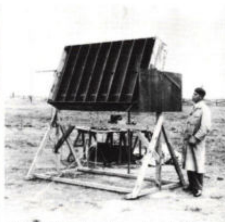
Ook in Duitsland werd in de jaren dertig geëxperimenteerd met radio-overdracht in de hogere frequenties. Deze foto stamt uit 1935 en toont een van de eerste richtantennes die Telefunken gebruikte bij proeven in de omgeving van Berlijn.
